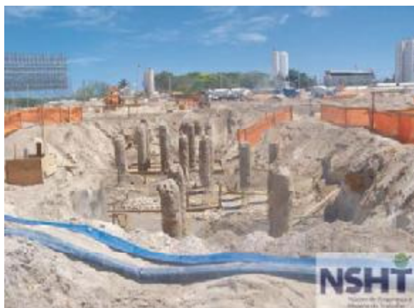
شکل 2. (a) مته های نمونه برداری مداوم؛ (b) نصب شمع ها (ی ساختمانی)
