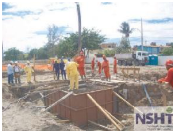
شکل 3. (a) بلوک های سیمانی برای پوشاندن شمع ها؛ (b) بلوک پوشیده شده سیمانی جهت اتصال تیرک ها (ی چوبی) به ستون
