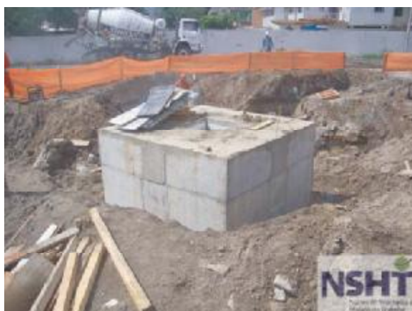
شکل 3. (a) بلوک های سیمانی برای پوشاندن شمع ها؛ (b) بلوک پوشیده شده سیمانی جهت اتصال تیرک ها (ی چوبی) به ستون
