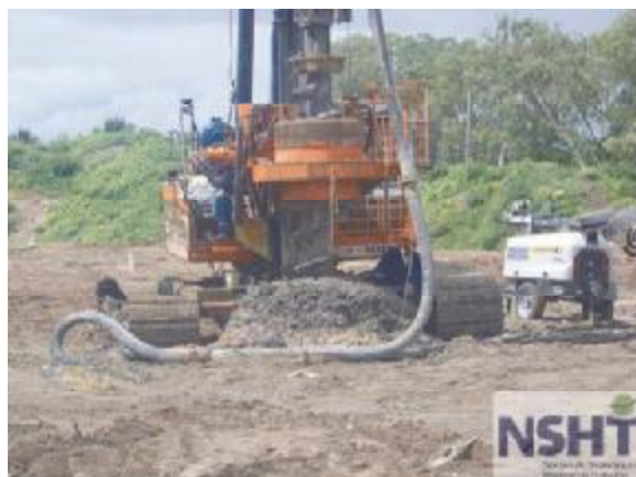
شکل 2. (a) مته های نمونه برداری مداوم؛ (b) نصب شمع ها (ی ساختمانی)
